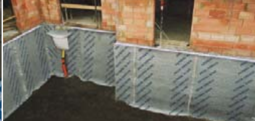
Dauerhaft filterstabile Drainage.
