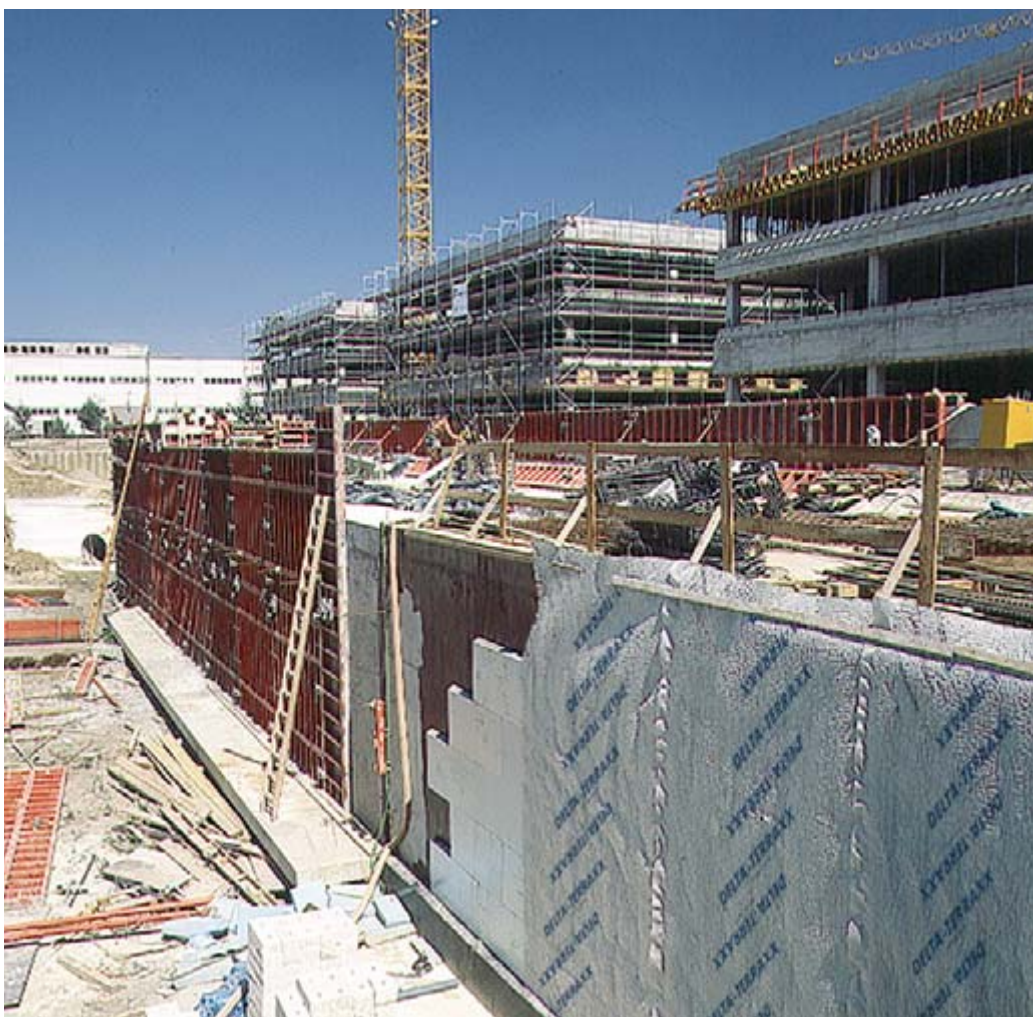
DELTA®-TERRAXX auf Perimeterdämmung bietet ein Höchstmaß an Sicherheit.
