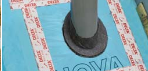
DELTA®-NOVAFLEXX einziehen und luftdicht verkleben.
