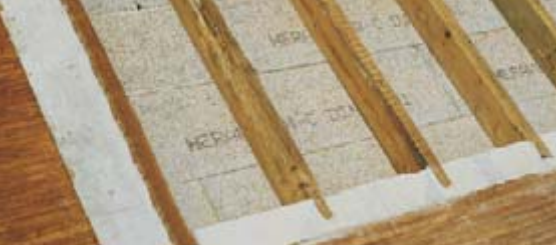
Deckung sowie Dämmung entfernen und Innenflächen glätten.
