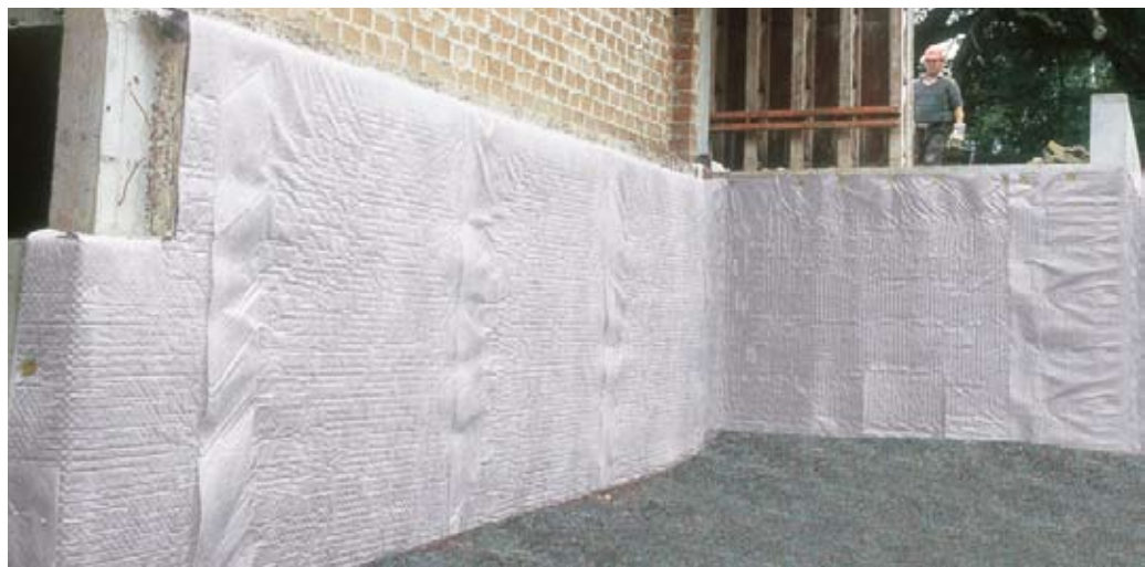
Bessere Druckverteilung auch zum Schutz von Dickbeschichtungen
