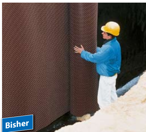
Bisher Viele Noppenbahnen drücken die Noppen auf die Bitumenbahn oder die Dämmung.
