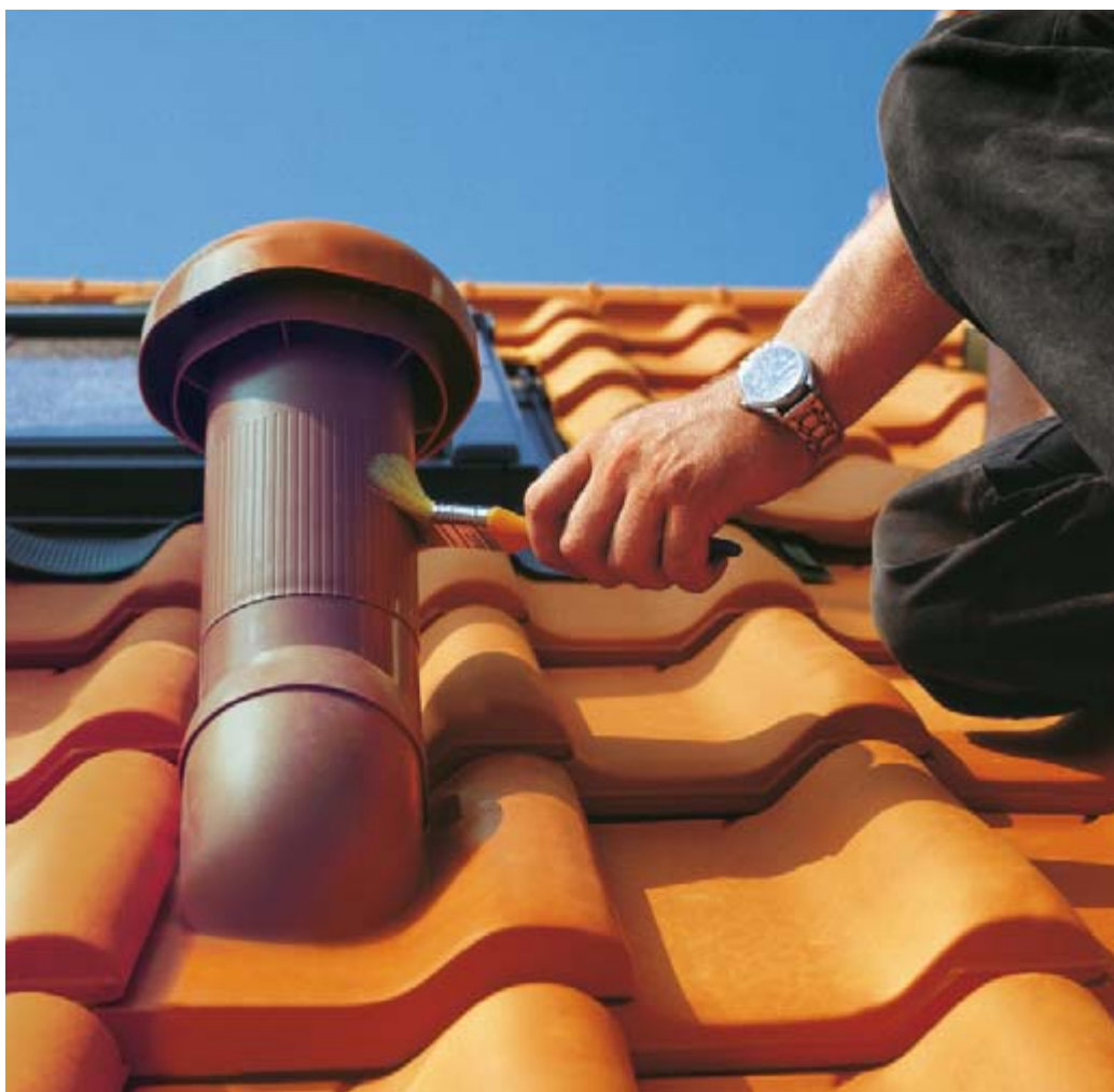
DELTA®-DACHCOLOR kann durch Rollen, Streichen oder Spritzen sicher und sauber verarbeitet werden.
